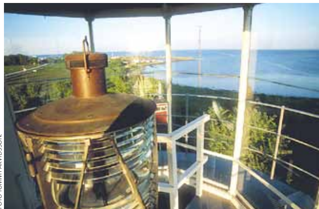
Lyshöjd över havet: 19,6 m. Lysvidd: 2 Nm. Nuvarande optik: 4:e ordn (500 mm) dioptrisk trumlins med 5+5 inslipade ringar. 20W lampa.
